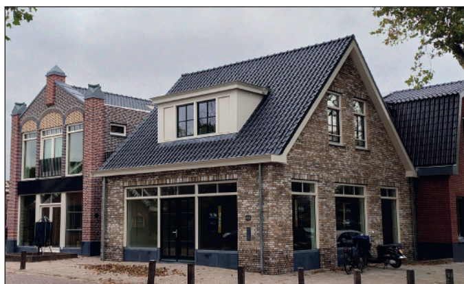
Het vernieuwde maar in originele staat herbouwde pand in 2025
