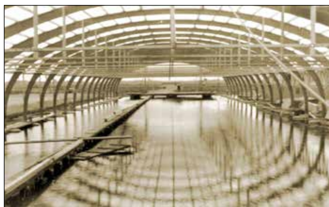
De lighal in aanbouw 1930 (foto m.v. Van Dongen)
