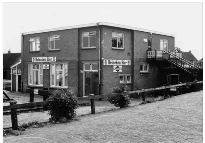
Al snel liet de SSDN een nieuw café bouwen, zij het in een zakelijke strakke stijl. Veel geld voor franje was er ook niet want naast de uitkering van de brandverzekering moest een groot bedrag worden geleend voor de herbouw. In oktober 1963 werd de nieuwbouw opgeleverd.
