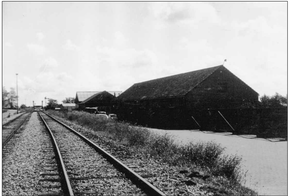
Het talud aan de westzijde van de hefbrug in 1967. Het sein voor de brug staat op de stand 'onveilig, stop', omdat de hefbrug in de geopende stand staat. Het sein en de brug werden bediend door de sluiswachter.
