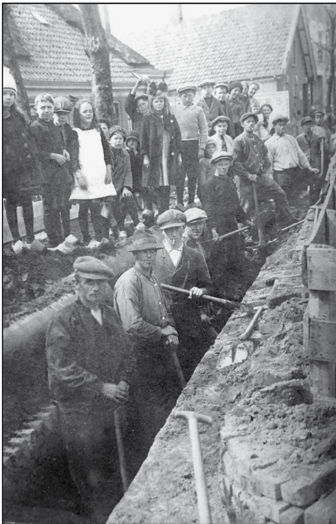
Foto uit het boek Het dorpsleven van de Langedijk, blz. 88. Aanleg van de waterleiding in Oudkarspel.
