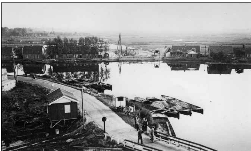
Onder zien we nog een stukje van de Klaas van der Molenbrug. Aan de overkant de Sluiskade met in aanbouw de nieuwe sluis. Foto uit 1941.
