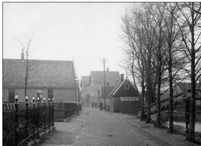
Situatie voor de brand: het Langedijker Warenhuis kijkend naar het zuiden, met links de bakkerij van Bullooper
