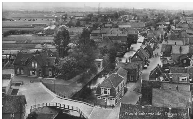
De in 1952 gebouwde brug van het gasfabriekterrein naar de Dorpsstraat gefotografeerd vanaf de toren van de RK Sint Jan de Doper kerk
