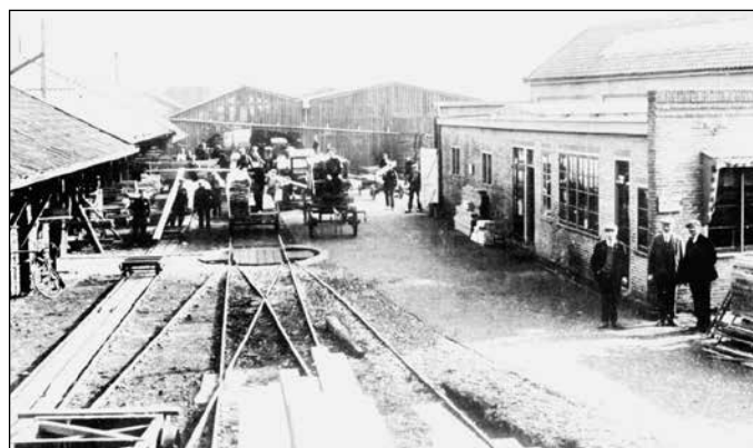
Vervoer op het bedrijfsterrein ging met lorries. Op het midden van de foto is een draaischijf zichtbaar (foto 1930)
