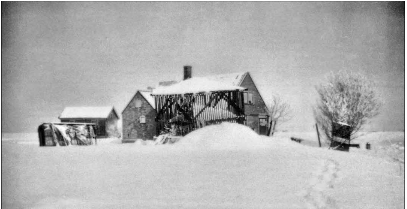
Het Kerkmeershuis vanuit het zuiden gezien in de winter van 1955. Van links naar rechts: het gemaal, koeienboet, de woning met daarvoor de kapberg en de wc boven de sloot.
