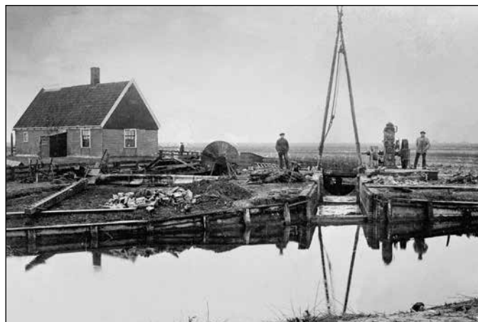
Op de exacte plek van de afgebrande Kerkmeermolen werd in 1915-1916 het machinegebouwtje neergezet. De motor die in de molen stond was bij de brand behouden gebleven en kon worden hergebruikt. Hetzelfde geldt voor de vijzel. Links op de foto het Kerkmeershuis en daarvoor de restanten van de molen.
