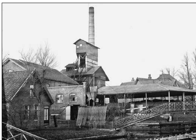
Voor de overdekte steenkolenopslag en daarachter de blustoren
