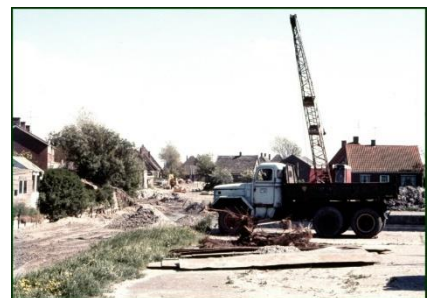
Werkzaamheden ter hoogte van de zuurkoolfabriek van Hart
