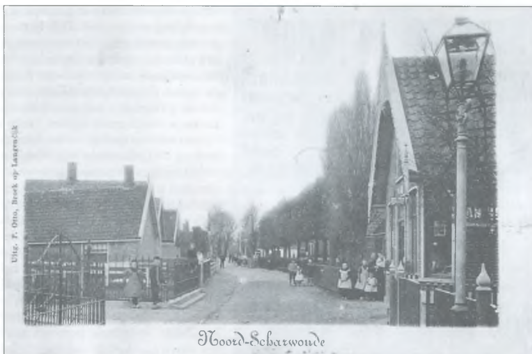
Ansichkaart uit ca. 1900, het pand rechts is het bewuste pand.
