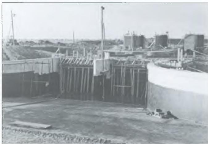
De bouw van het nieuwe gemaal vordert al
