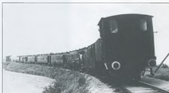
Broek op Langedijk heeft zijn aftakking van het spoor naar de veiling
