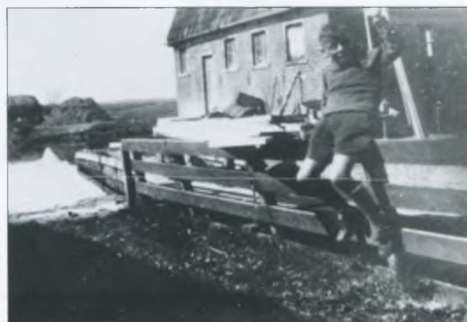
De timmerwerkplaats aan slootkant
