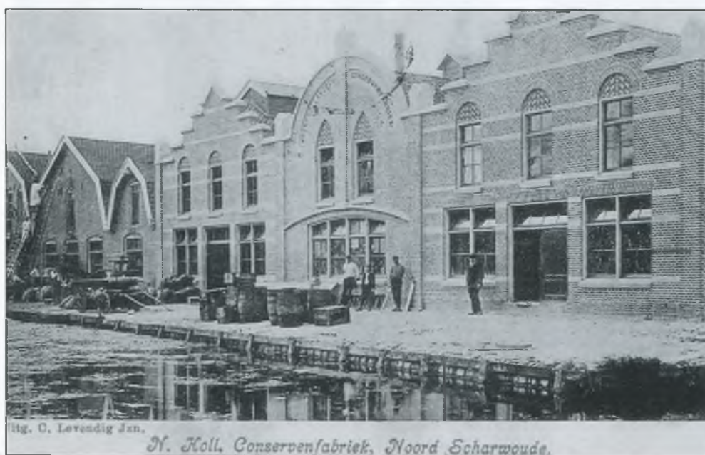
De gevel van de Conservenfabriek zoals die er oorspronkelijk uitzag
