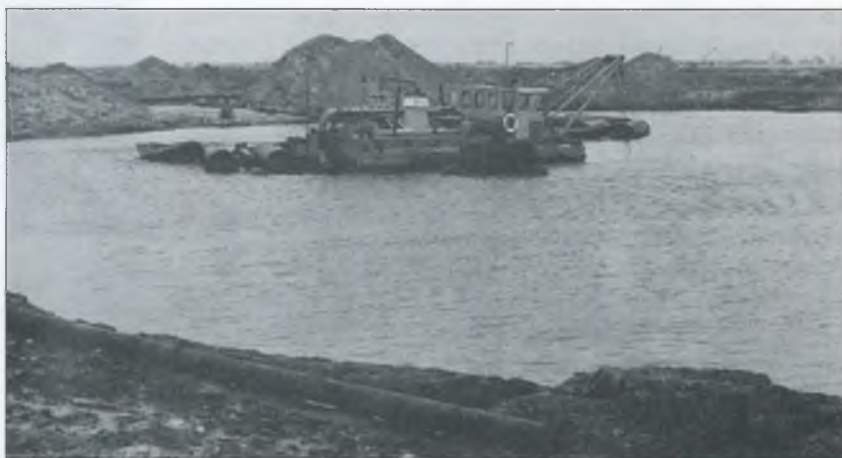
De zandzuiger volop in bedrijf bij de aanleg van het recreatiemeer Geestmerambacht, omstreeks 1973 (foto uit nummer 3 van een uitgave van de Streekverbeteringscommissie Geestmerambacht)
