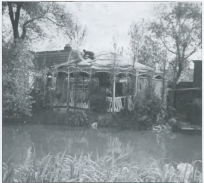
De hobbelende geit is in aanbouw
