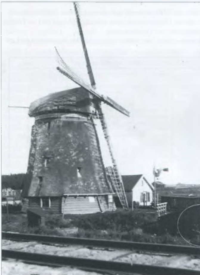
Vlak langs molen 'H' werden de rails aangelegd. De foto is genomen vanuit noordwestelijke richting. In de verte is nog de Amerikaanse windmolen te zien die aan de Waarddijk stond.
