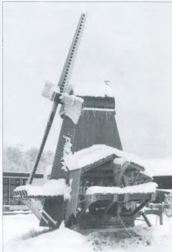
Ter gelegenheid van het 175-jarig bestaan werd in 1980 een schaalmodel van de eerste paltrok-molen van Cornelis Eecen gebouwd. Een paltrok is een vroeg voorbeeld van een houtzaagmolen. De naam is afgeleid van een klederdracht van Duitse emigranten uit de Pfalz, waar de vorm van de molen aan deed denken.
