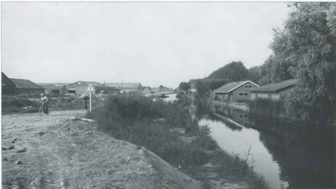
Zo was de situatie op 21 augustus 1978 op het Veilingterrein. De spoorrails werden opgeruimd, de oude Wuyversloot gedempt en een brede weg aangelegd. Rechts de achterkant van de Handelskade.
