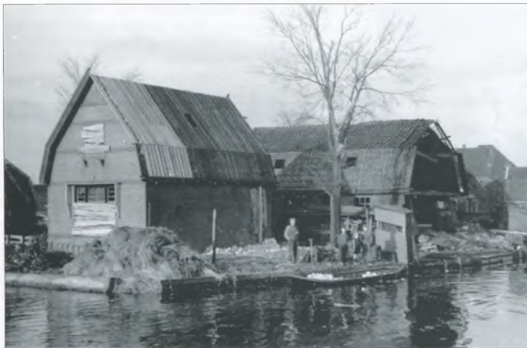
De huizen bij de sluis van Oudkarspel werden zwaar beschadigd door de bommen. Het huis was van de familie Kramer.(2 december 1943)
