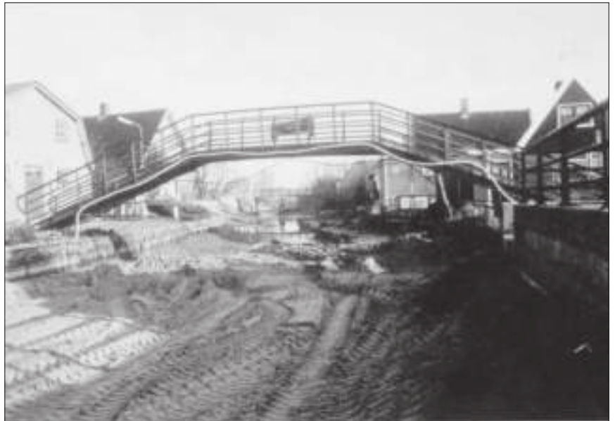
De brug bij Engelenburg in Oudkarspel overspant een met zand volgestorte Voorburggracht. Deze brug was als een van de eersten aan de beurt om gesloopt te worden. De snijbranders wisten hier wel raad mee.
