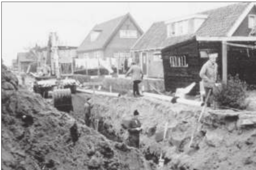
De rioolaanleg naderde intussen Zuid-Scharwoude.
