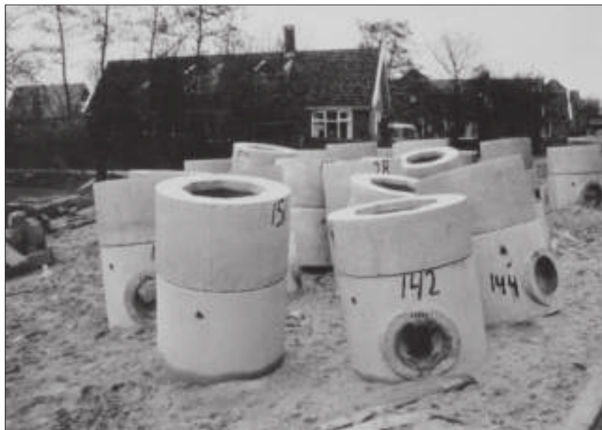
Op een inmiddels gedempte Voorburggracht staan de rioolputten klaar.
