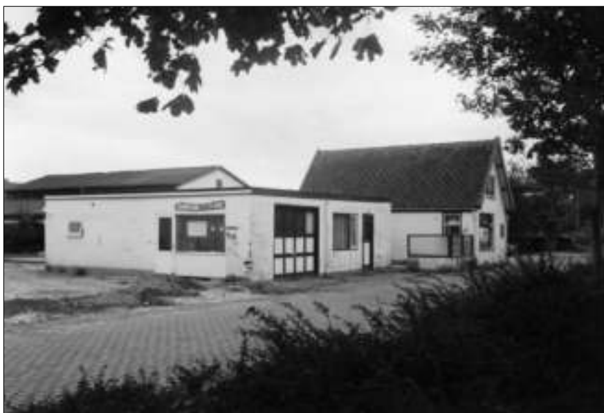
Vlak voor de sloop zag het bedrijf van Rem Komen aan de Koog er zo uit. Op de zijmuur is nog het bord 'Camping De Duizend Eilanden' te zien.
