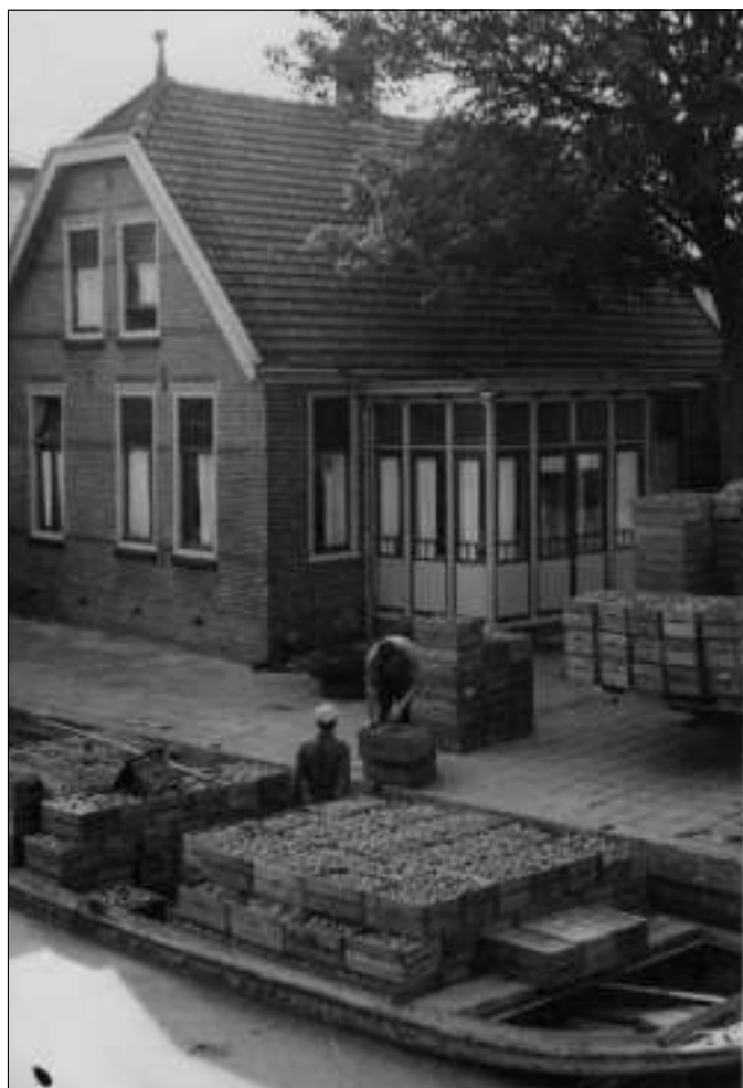
Firma Kuiper bij de Mosselenbrug
