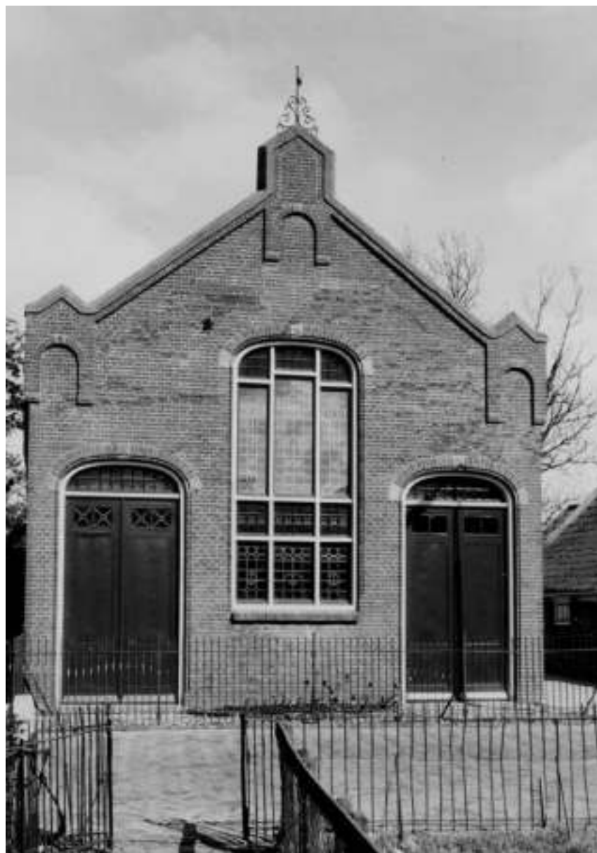
De Doopsgezinde kerk van Broek op Langedijk met de oude, helaas gesloopte voorgevel.
