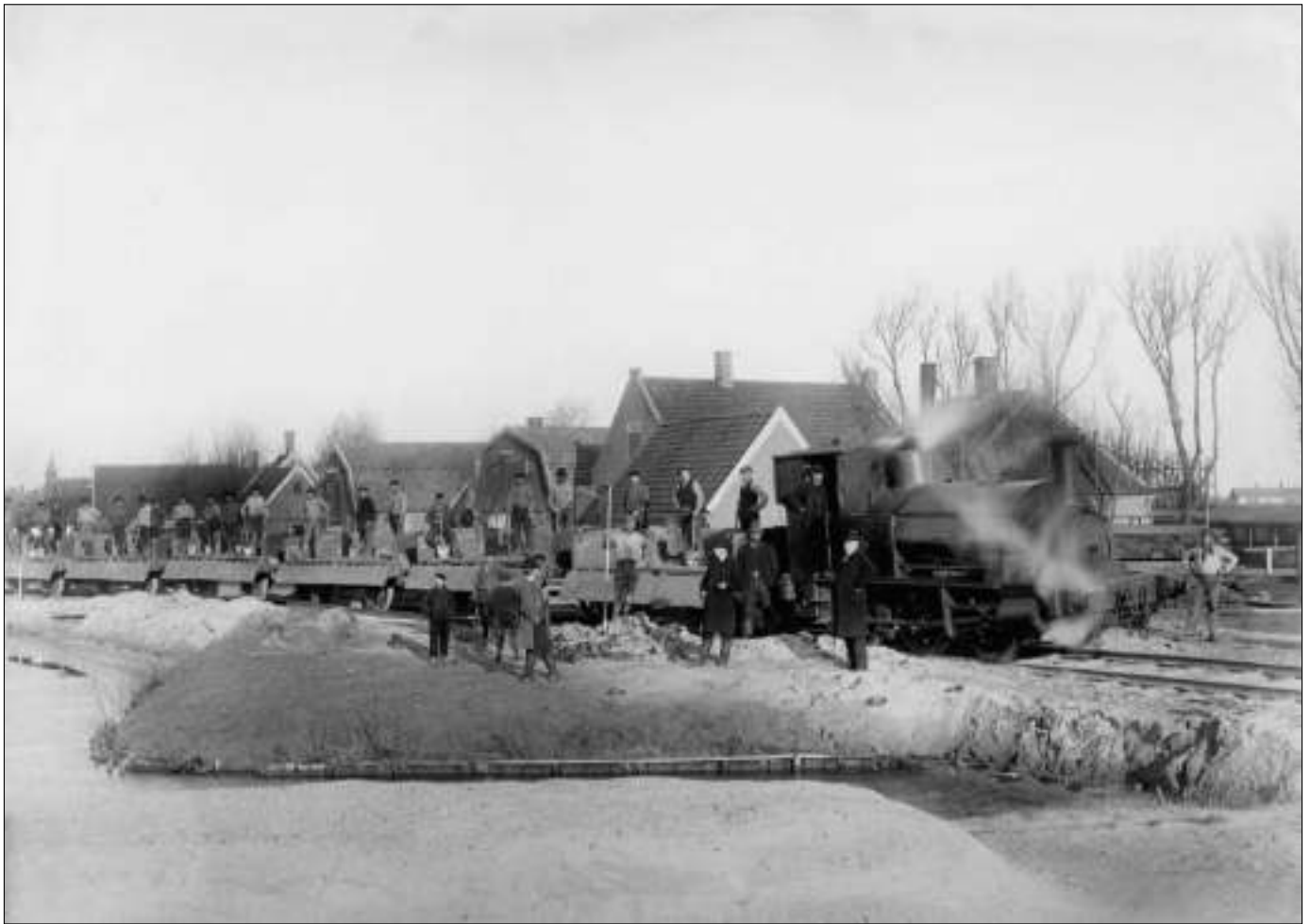
De aanleg van het Broeker spoortje in 1902. Hier kruist de spoorlijn richting het stationsemplacement de Dijk. Links is in de verte de NH kerk te zien.
