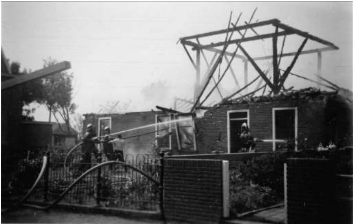
De brandweer is aan het nablussen. Alleen de muren en het vierkant staan nog overeind
