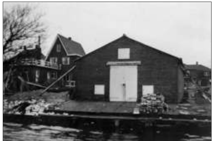
De achterzijde van het nieuwe koelhuis vanaf de Voorburggracht gezien
