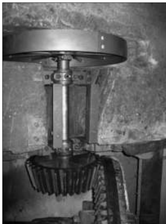
Het begin van de restauratie van het maalwerk. (foto Charles Barten)
