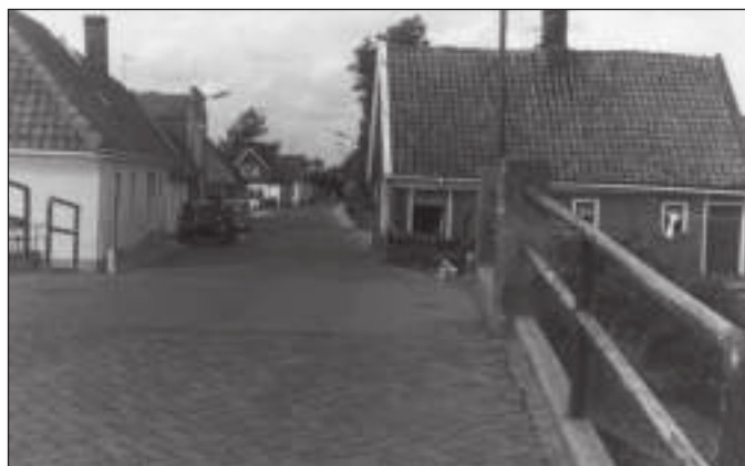
De oprit van de Broekerbrug in de richting van Zuid-Scharwoude. De brug verdween bij de ruilverkaveling begin jaren '70.
