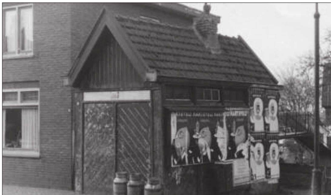
Het oude brandspuitboetje van Zuid-Scharwoude vlak voor de sloop in 1956. Let op de reclameplaten en de melkbussen die door de melkrijder van Excelsior in Heerhugowaard werden opgehaald. (foto fam.Smit-Buiter, Bergen NH)
