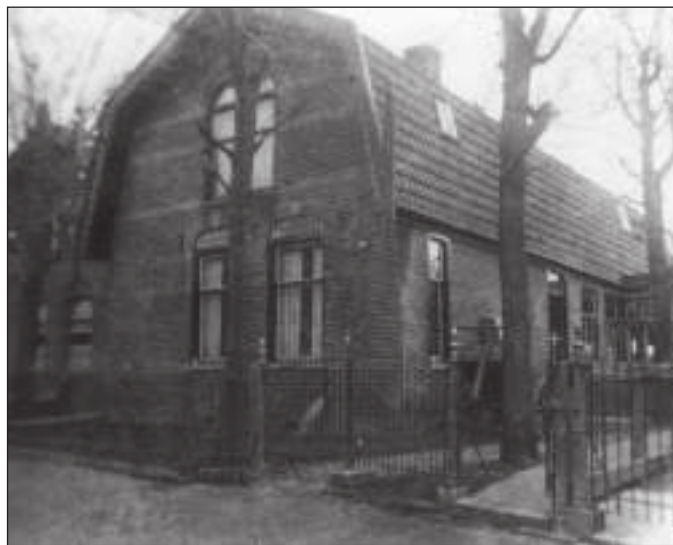
Het huis van timmerman Jacob Zijp met daarnaast achteraan de timmerwerkplaats. Achter de boom is nog een handwagentje te zien.
