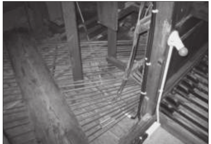
De diagonale tractuur van het pedaal en tweede klavier (foto Dick Barten)
