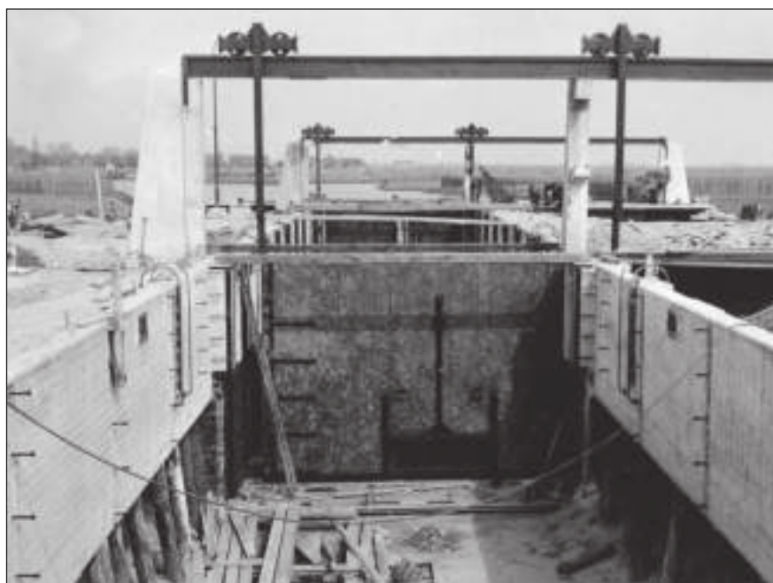
Foto van de bouw van de nieuwe sluis in 1940/1941
