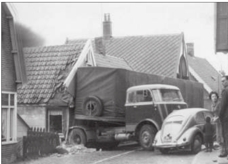
De truck met oplegger van Leegwater ramt het huisje.
