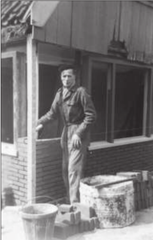
Cor Rutsen metselt de nieuwe muur op.
