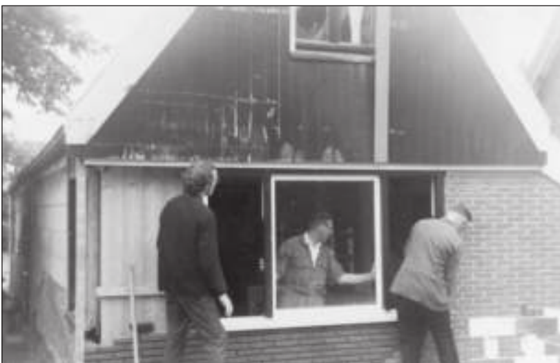
Aris Jan Kout en zijn vader Jan stellen het kozijn voor het raam. Aan de binnenkant staat Jan de Ruiter, werkzaam bij Rutsen.
