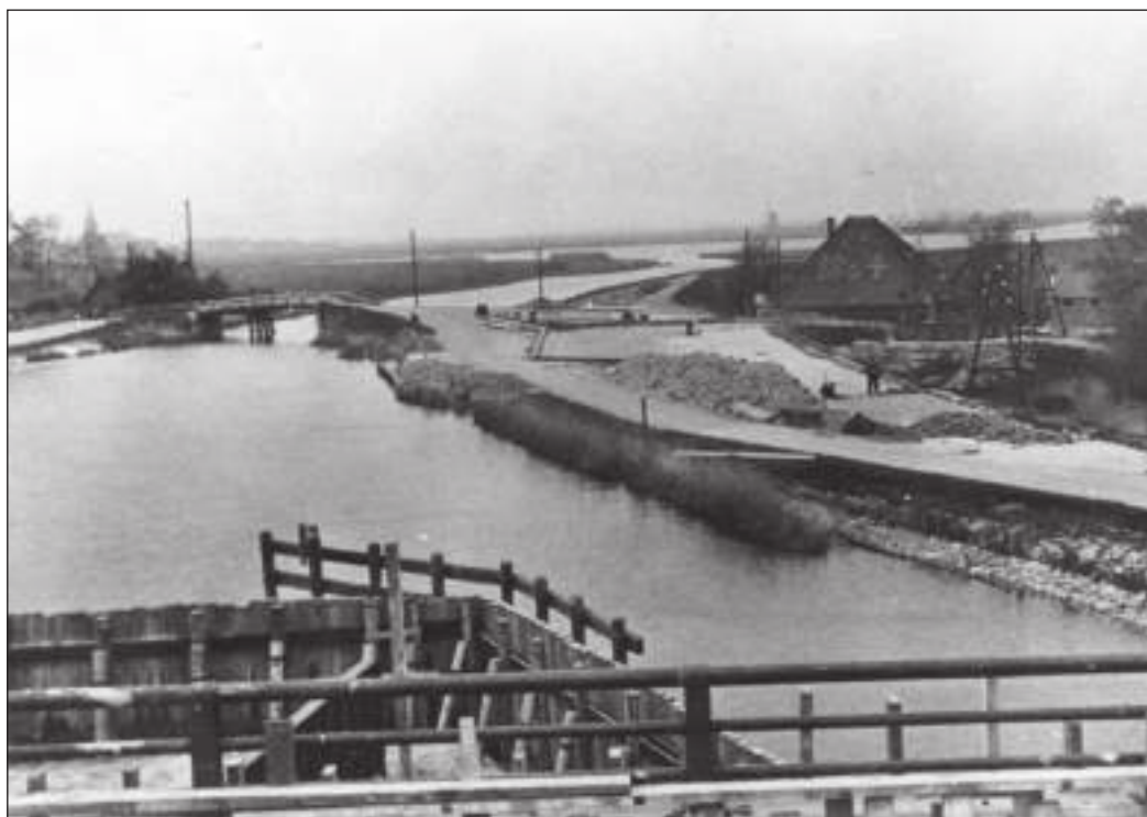
Links is hier de oude Roskambrug nog te zien. De voorbereidingen voor de bouw van de Roskamsluis zijn hier al begonnen. Het nieuwe huis, op de plaats van de Roskamboerderij, is al gesloopt. Op de achtergrond Het Waardje.
