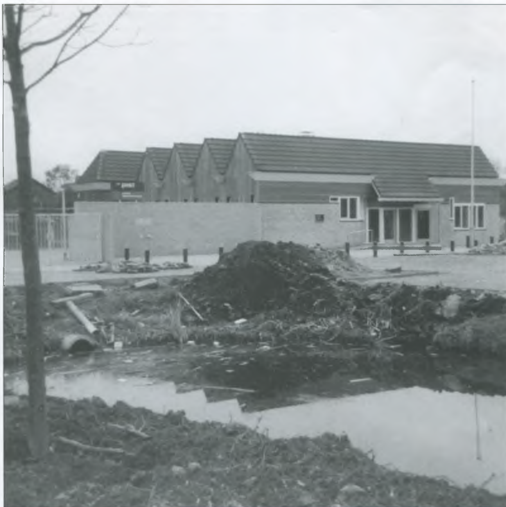
Het nieuwe postkantoor aan de Voorburggracht vlak voor de oplevering in november 1983.
