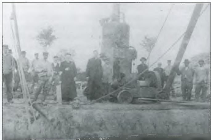
De stoomheimachine om de eerste palen de grond in te slaan.
