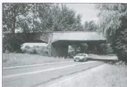
De Langebalk vlak voor de aanleg van de fietsbrug, gezien vanuit het zuiden.
