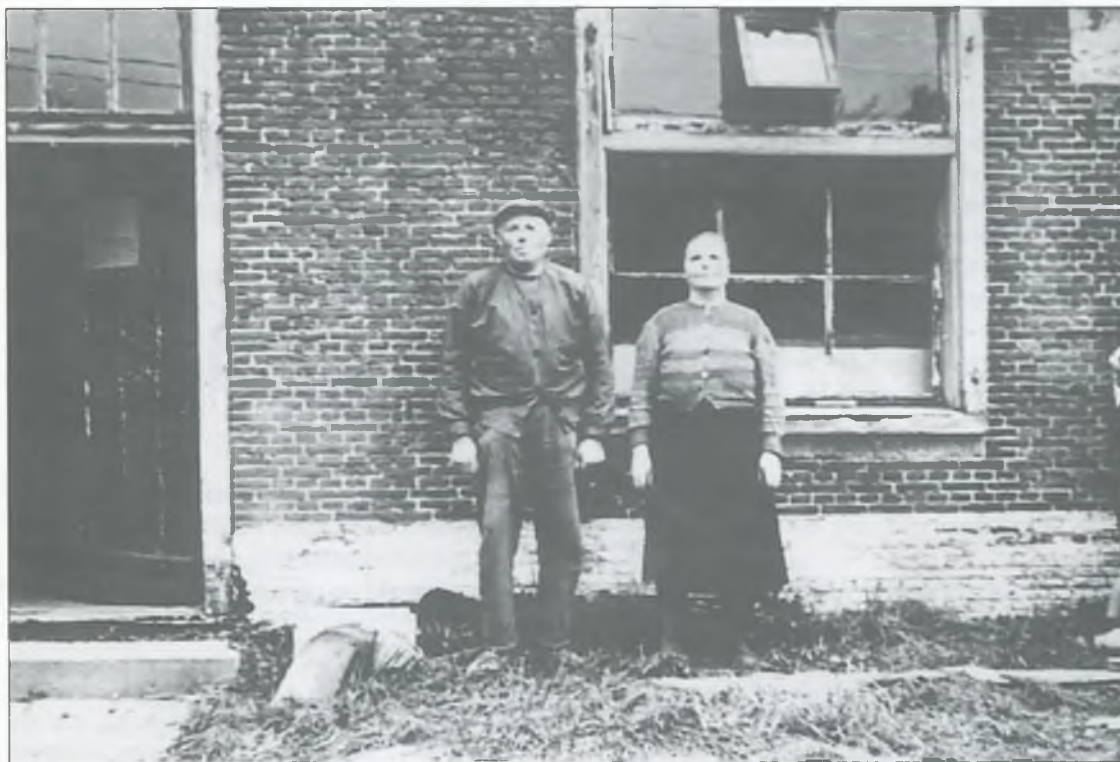
De Noord-Hollandse stolphoeve werd het laatst bewoond door Jan en Betje van Diepen. Het gebouw verkeerde, zoals is te zien, in een verwaarloosde staat
