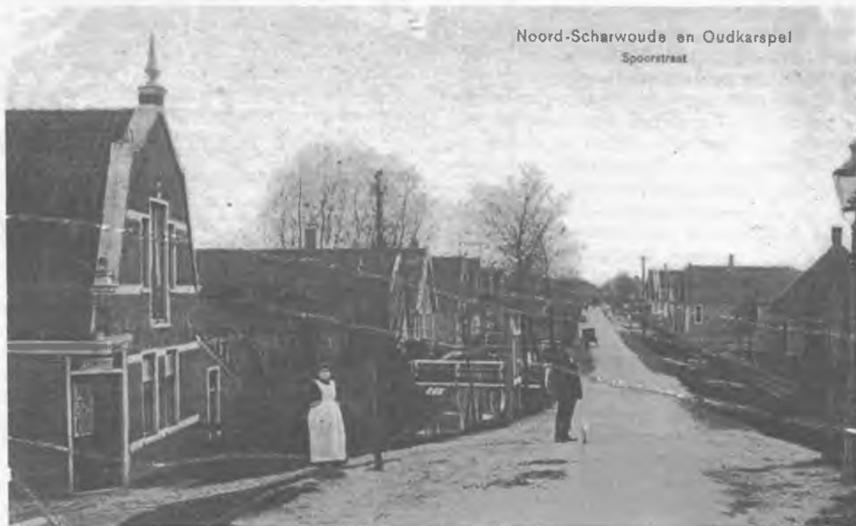
De Spoorstraat naar het westen toe met links café De Hut.
