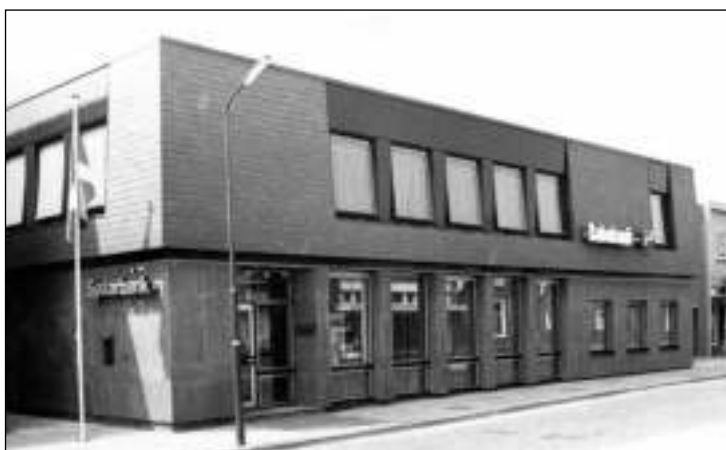
Het verbouwde kantoor aan de Dorpsstraat, tegenover Concordia
