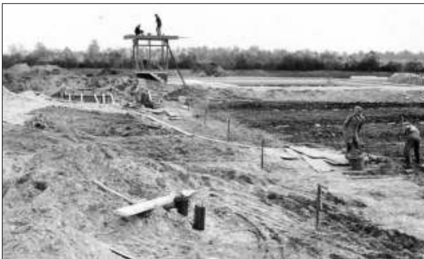
Het zwembad in aanbouw door firma De Geus (online fotoboek van Sport Service Langedijk)
