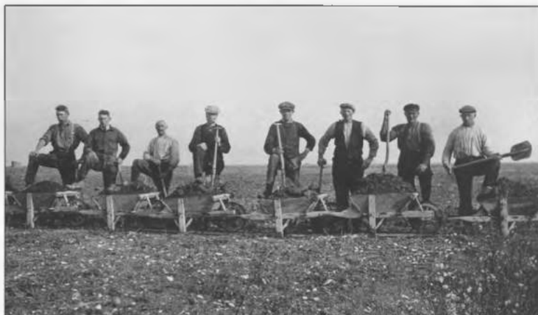
Een groep werklozen voor het graafwerk in het kader van het kanalenplan.
