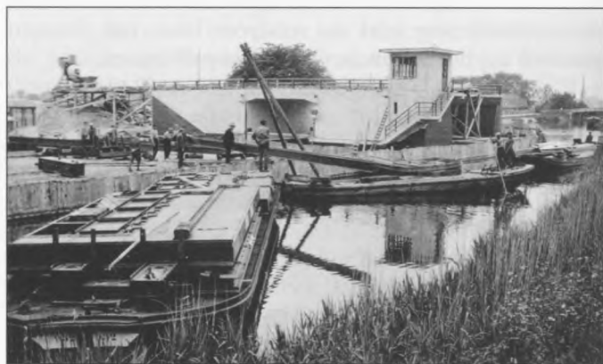
De situatie van de bouw van de brug en de sluis op 17 juni 1935
