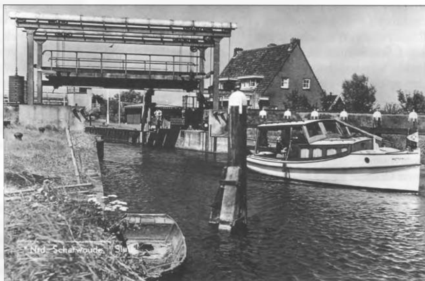
De zuidkant van de sluis met de spoorbrug
