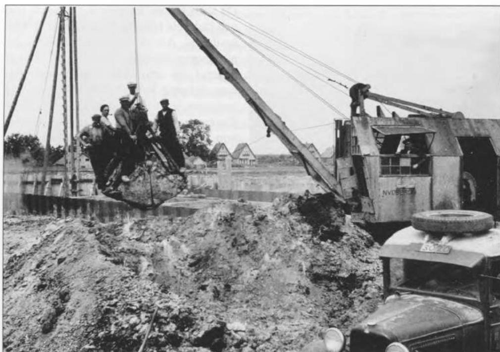
Graafwerkzaamheden in het kader van de bouw van de sluis door de firma Oberon
