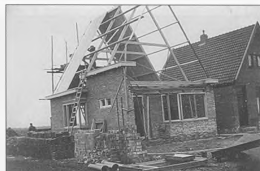
Laanweg 18 in aanbouw
