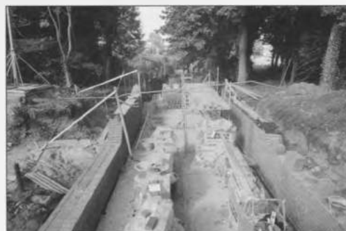
De werkzaamheden in volle gang
